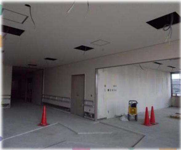
桜から新緑へ季節が移り変わる中、総合福祉センターの改修工事は配管工事を終えて天井板の再設置が進んでいます。
